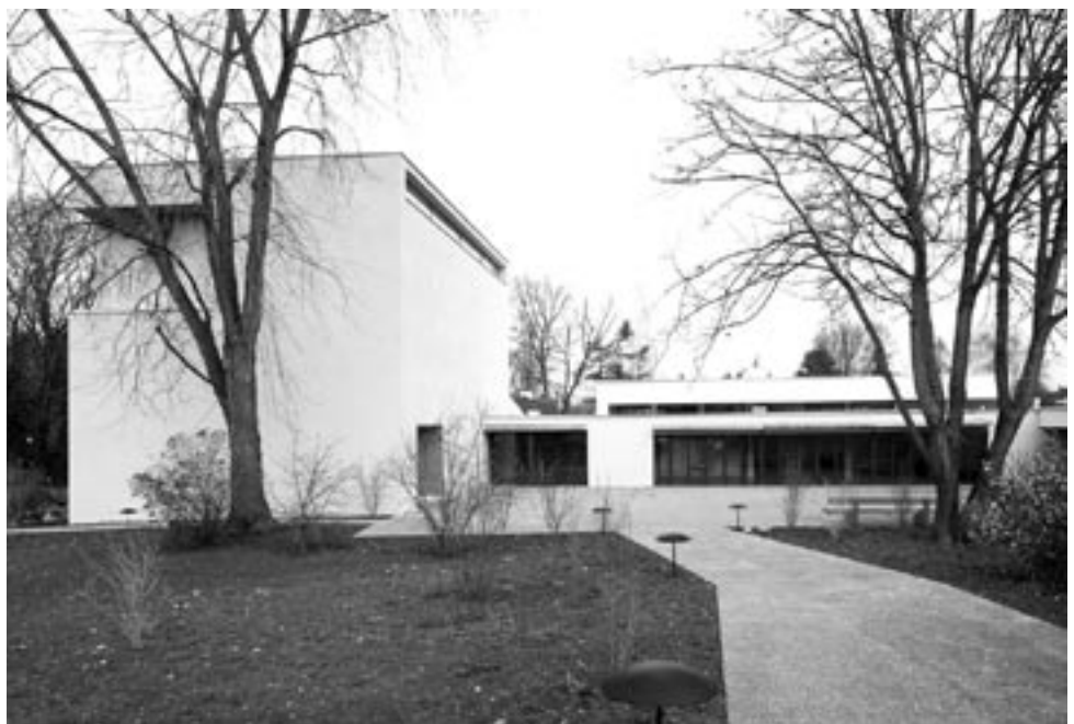
Binningen, Paradieskirche und Kirchgemeindehaus, Arch. Hanspeter Müller, 2006
